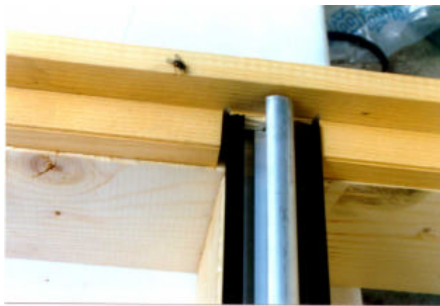
Figura 5.10: Profili di alluminio a T per l'appoggio del vetro con inseriti i gommini portavetro.
