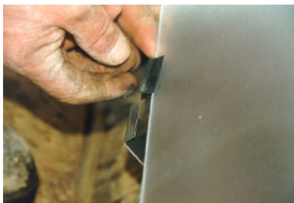
Figura 5.12: Montaggio del gommino portavetro per la protezione dello spigolo della lastra.
