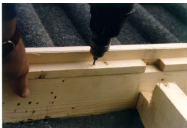
Figura 5.3: Montaggio del profilo in legno per la chiusura superiore.
